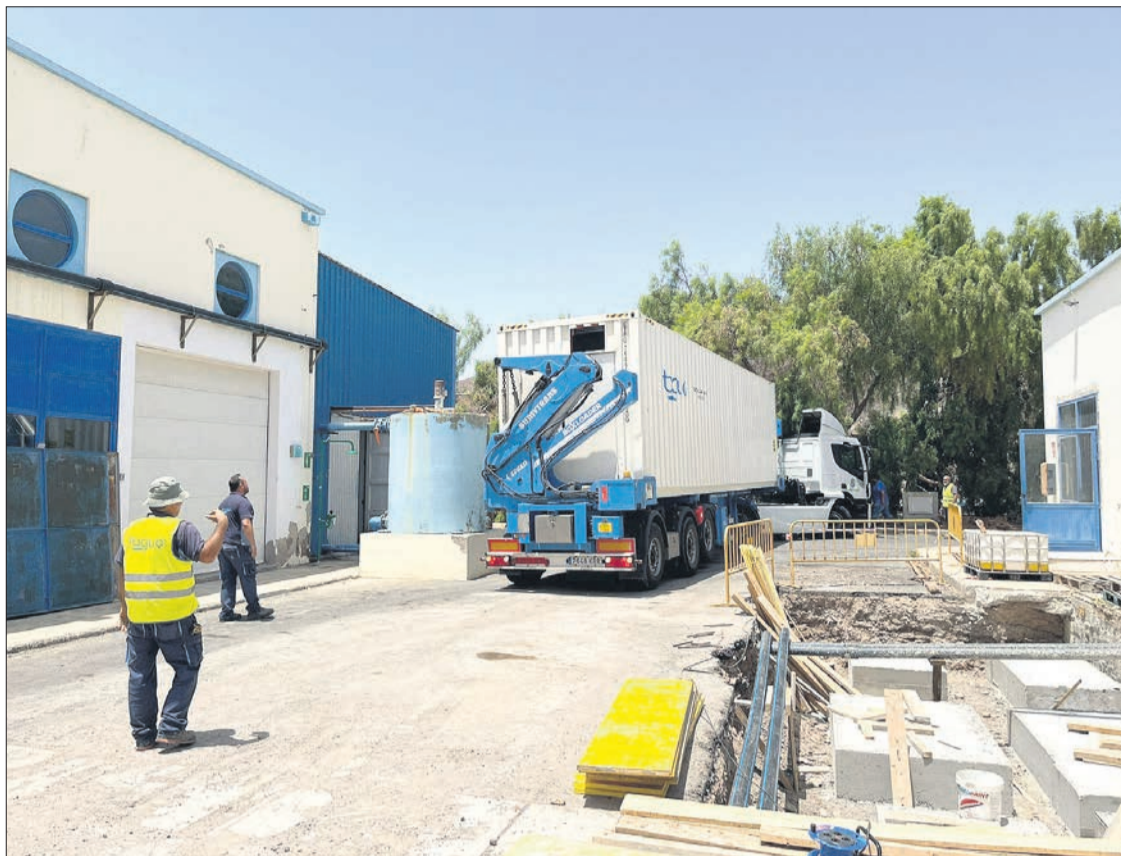
Operarios instalan la desaladora portátil en la planta de Gran Tarajal.
