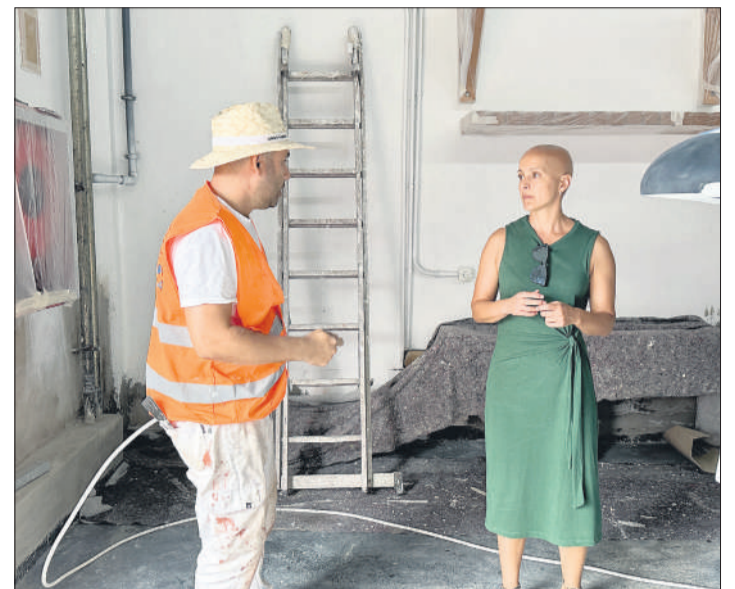
Gleiber Carreño, visitando una de las obras realizadas en La Oliva.
