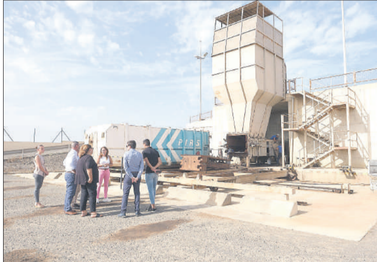
Momento de la puesta en marcha de la planta de transferencia.
