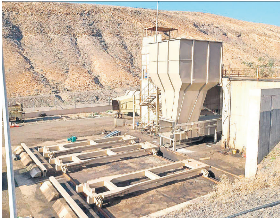
Planta de Transferencia de Mal Nombre, en el municipio de Pájara.
