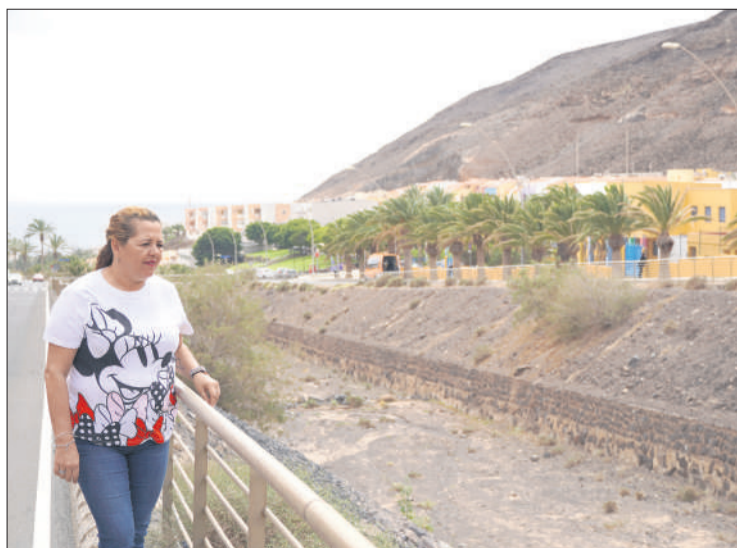
Acosta comprueba los trabajos realizados en el Barranco del Ciervo.
