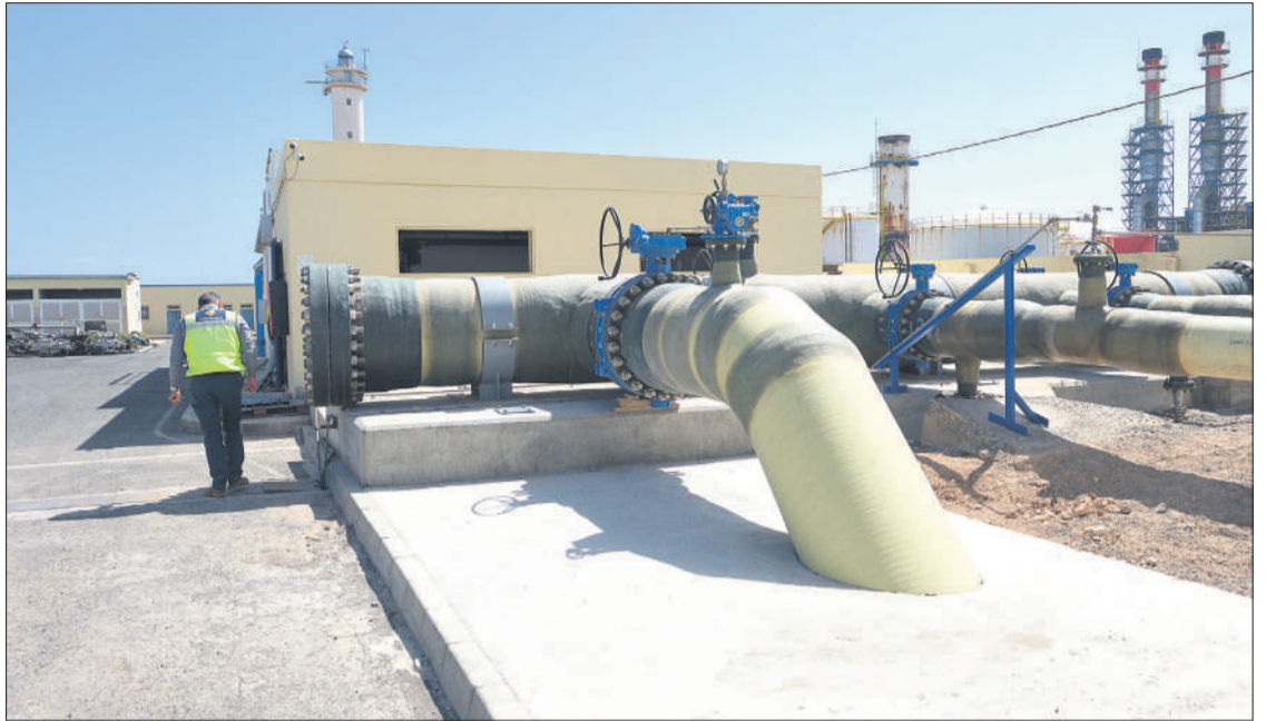
Obras que permiten mejorar la impulsión del agua desde la EDAM de Puerto del Rosario a La Herradura.
