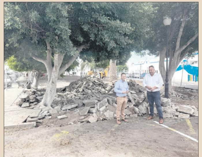
NUEVA ZONA VERDE EN LA LAJITA. El Ayuntamiento de Pájara ha iniciado los trabajos para la creación de la nueva zona verde de La Lajita, que estará finalizada el próximo año, con el objetivo de mejorar la imagen de la localidad y del Municipio, así como para servir de espacio de ocio y de encuentro para la ciudadanía y visitantes. El alcalde de Pájara, Alejandro Jorge, y el primer teniente de alcalde y concejal de Obras, Alexis Alonso, estuvieron presentes en el inicio de estas obras, cuyo presupuesto es de 722.074 euros.
