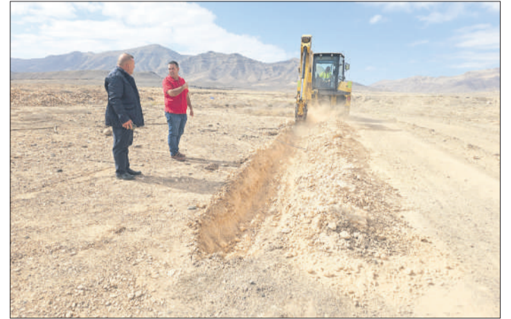
Visita a las obras de canalización en Los Alares.
