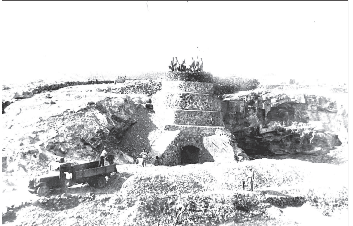
Primer horno de los seis que actualmente se encuentra en Risco Prieto, de la familia Castañeyra.
