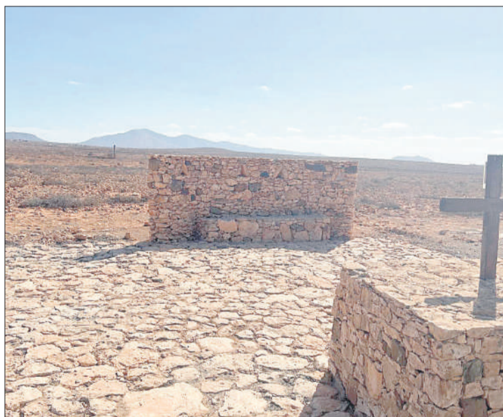
Antiguas cruces rehabilitadas.
