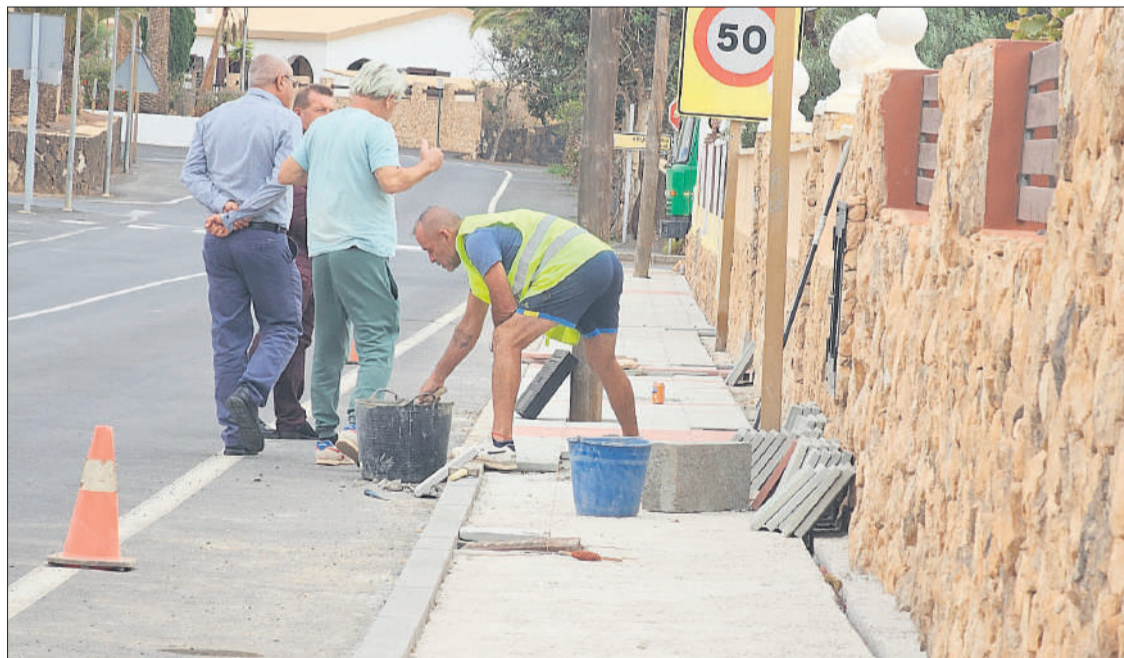
Matías Peña y Juan Cabrera, durante la visita a las obras de las nuevas aceras en Triquivijate.
