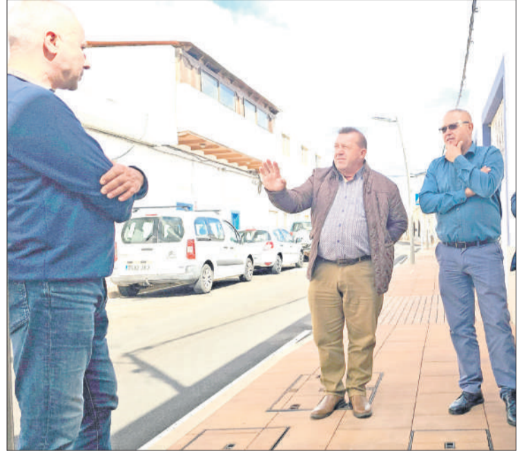
Alberto, Peña y Cabrera visitan las obras receptionadas.
