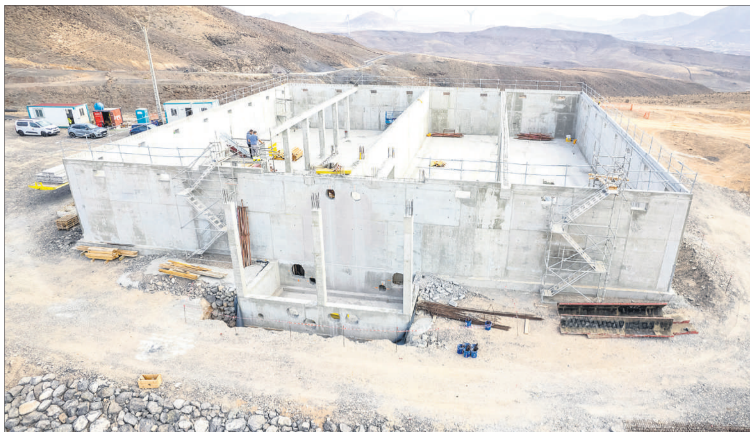
Vista aérea de las obras en el depósito de Guerime.
