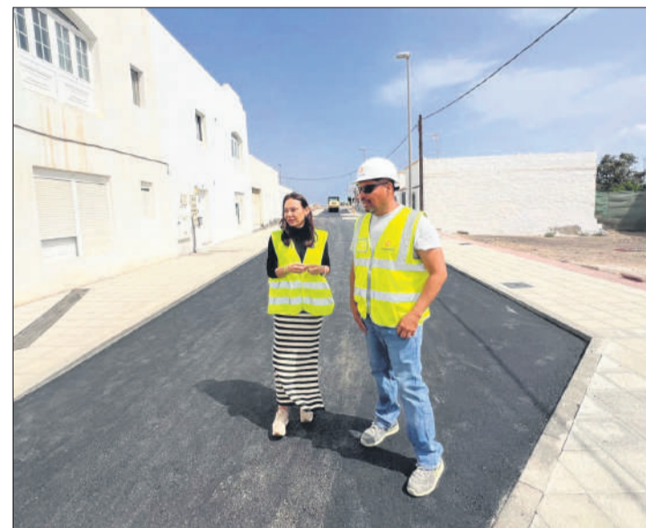
Ana Hernández, concejala de Obras, visita los trabajos realizados.
